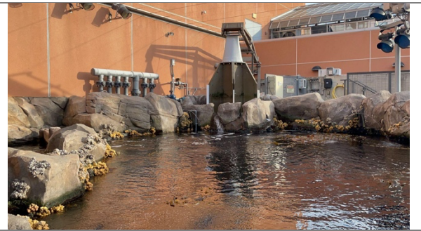
圖54 岩岸區的大型潮汐模擬池，透過造浪機利用機械動力產生的人工波浪，模擬真實海洋中潮汐與海浪的運動。
