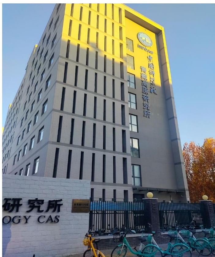
圖 18. 位於北京市朝陽區林萃路的青藏高原研究所。
