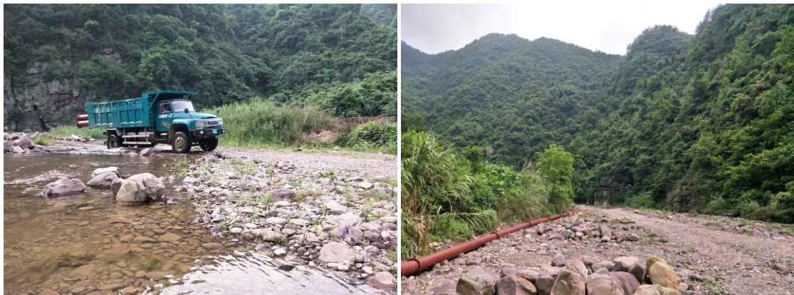
圖 90~91、卡車載著大水管進入溪谷，裡面有敷設取水管線
