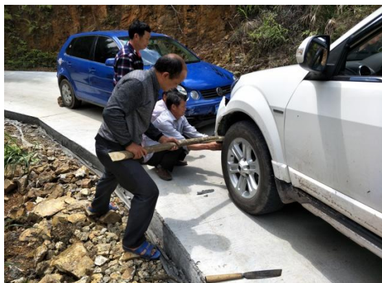
圖 104、用樹幹矯正卡住輪胎的鋼板
