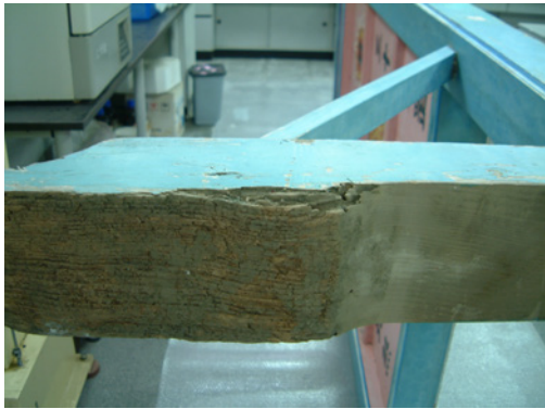
圖 22. 腳座腐蝕情形 (攝影/王督宜)
