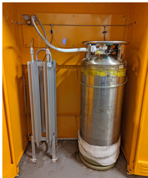
圖 2. 管線與桶壁結冰的液態氮儲存桶（右）與蒸發器（左）（攝影／呂釗君）
