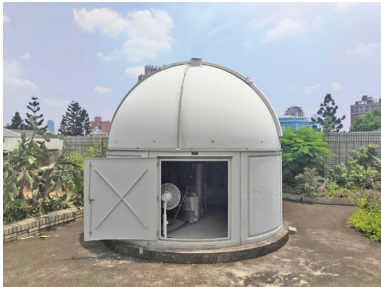
圖 8. 科博館天文臺完工照（攝影／王斌威）
