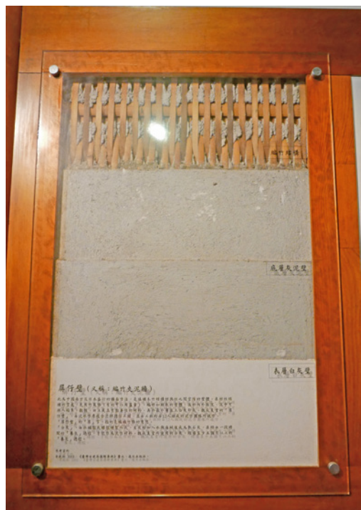
圖 16. 成美公堂修復後特別留下一面編竹夾泥工法示範牆（攝影／林韻丰）
