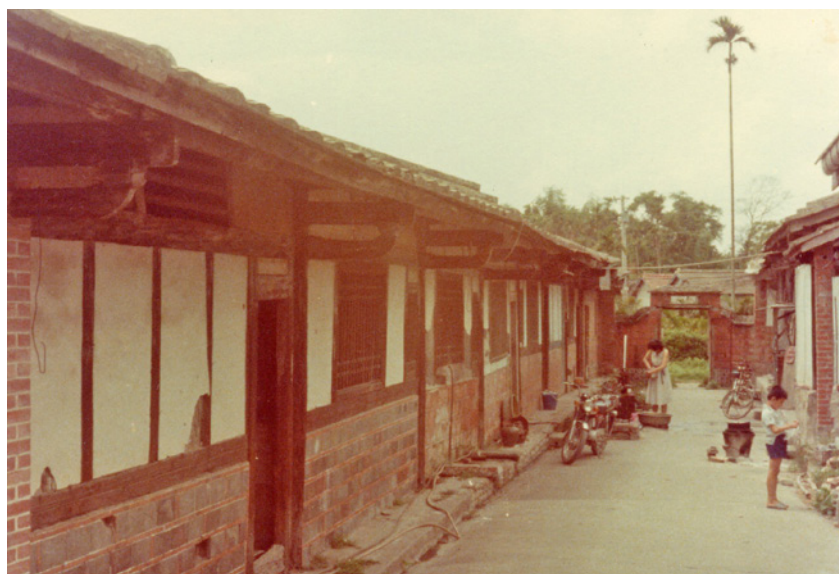
圖 17. 修復前的右護龍牆身為灰紅磚混用的斗子砌磚牆，而上半部則是客家地區特有的大面積編竹夾泥白牆，以反射明亮光線，方便婦女工作。(圖片來源／頂新和德文教基金會)
