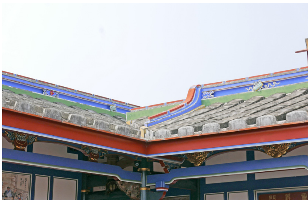
圖 13. 第一進的左右落鵝間與內護龍間的屋頂交會處，採用有別於閩式建築的客家「轉溝」構造。（攝影／林韻丰）
