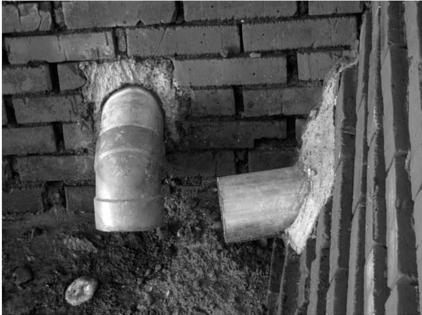
圖 6. 舊埤鹽田的排水系統，改以水泥將水管埋入紅磚的方式進行，而非過去以地勢高低做安排（攝影／楊凱成，2010）。
