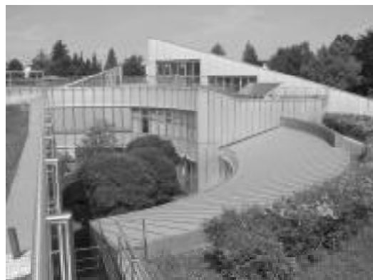
圖6. 兩棟圓形建築之一的天井，右下方為圖書館，後方為演講廳的三角形屋頂，以及太陽能電板。
