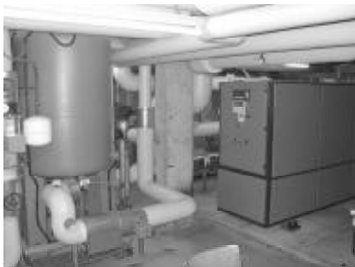
圖7. 吸收熱泵(左)及氣電共生系統(右)
