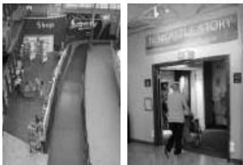
圖14. 加寬的坡道、電梯及走道，讓坐輪椅的觀眾得以暢行無阻。
