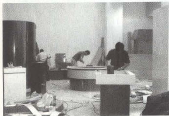
圖7.木作施工現場一景
