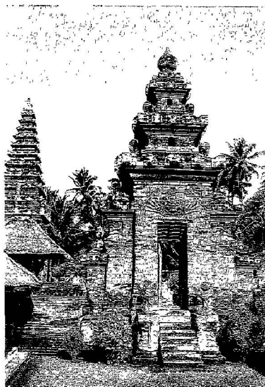
村廟建築中，中庭與前院的隔門。
