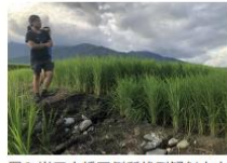
圖3 崙天大橋西側所找到疑似中央山脈斷層造成約半公尺的地表抬升。
