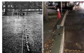
圖2 左圖：玉里國小北邊操場由小礫石所排成的邊線，受玉里地震影響向北左移動16公分(Bonilla,1975)。右圖：本次池上地震在玉里國小舊址人行道圍牆產生約10公分等級左移現象。
