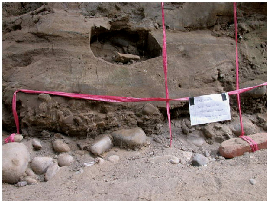
圖4 攝於「試溝」內TOT 施工後4個月(2000年8月10日)。可以見到未施工處(紅繩左邊)的砂層已崩塌成坑洞，但有TOT 施工(紅繩內區域)則安然無恙，由此可見TOT 的固結效果。
