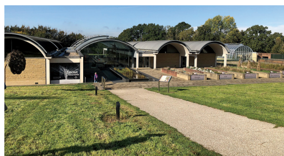
圖3 千禧年種子庫基地，地上一層樓，但重要的營運場則位在地下室。
