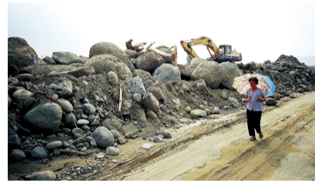
圖5 颱風過後的木屐寮村，怪手正在清理土石流的堆積物(劉興崧副大隊長提供)。
