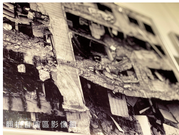
圖3 倒塌建築：臺北東星大樓
