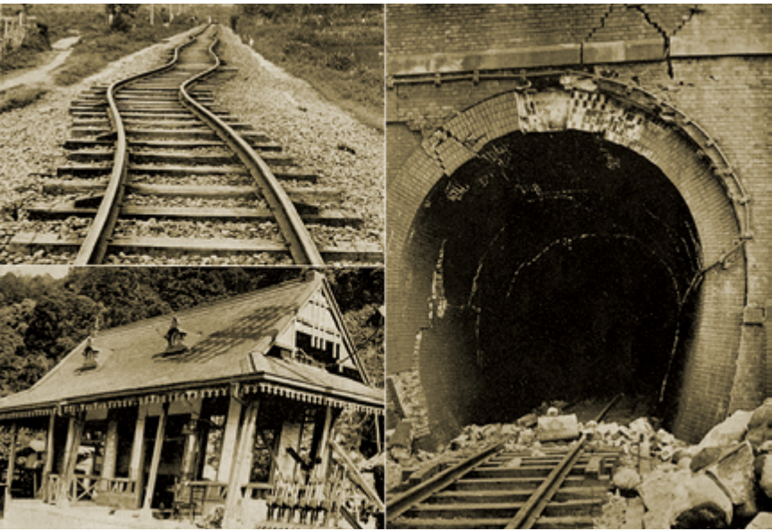
圖2 西元1935年新竹臺中地震時，鐵路損毀的照片，左下圖為舊「泰安車站」。資訊來源：昭和10年臺灣震災誌。
