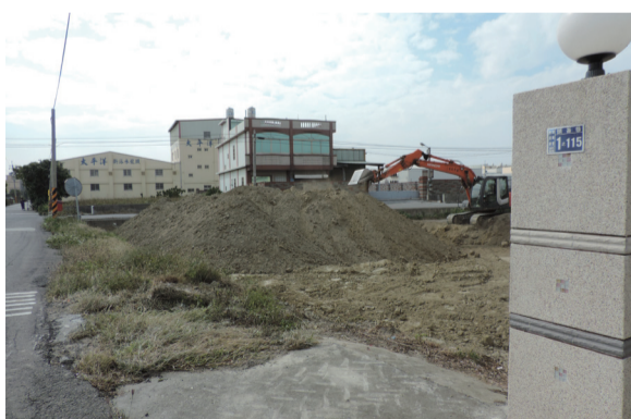
圖4 頂番婆遺址上土壤置換工程區
