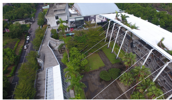
圖3 921地震教育園區利用鋼柱與鋼索構成的巨大頂篷作為北棟毀壞教室的遮蔽，避免風雨直接侵襲。
