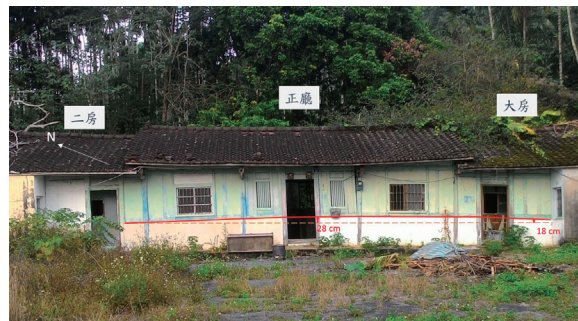
圖7 竹山槽溝東側的變形三合院(同上圖中建物)。中間的正廳為地震後抬升最高處(箭頭處)，紅色實線為地變後的牆界，虛線示意其原水平的位置。大門兩側的窗戶，因房屋不等量的抬升，而呈現約略向兩側傾斜。
