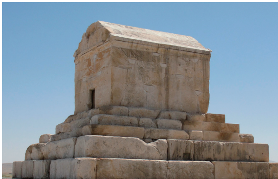
圖2 古波斯國王居魯士大帝的墓室—現存最古老的隔震建築（照片來源：維基共享資源 Truth Seeker 的作品）
