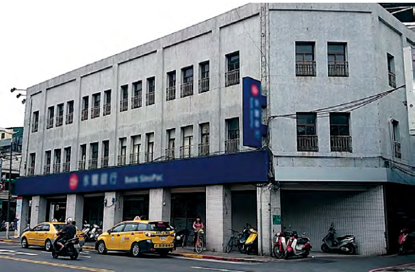
圖5 集集地震後新建築一樓騎樓柱密集且粗壯的案例
