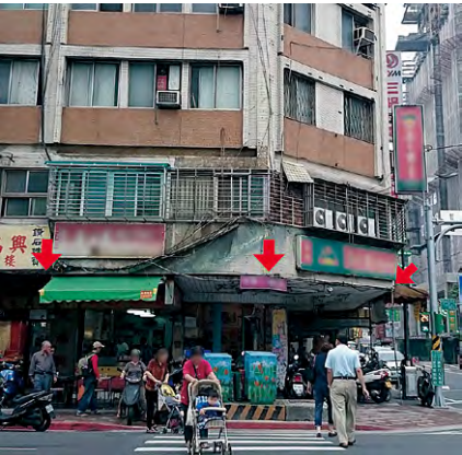
圖4 典型的軟底層建築(箭頭所指處一樓騎樓懸空，無外柱)
