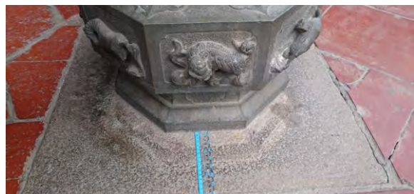
圖7. 龍山寺龍柱位移的痕跡，可推測此龍柱經歷多次地震。
