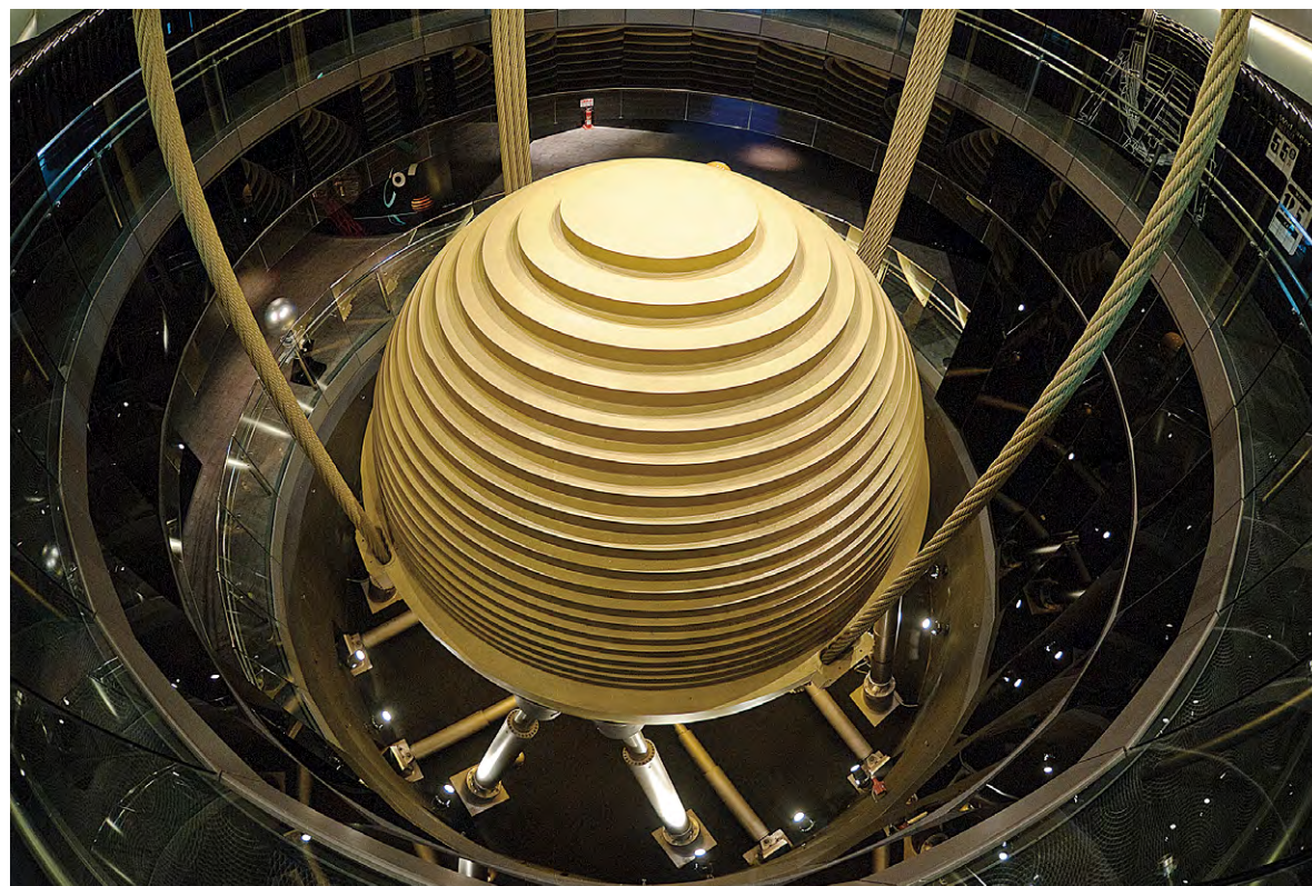
圖2 臺北101大樓風阻尼器(TMD)特寫近照(資料來源:維基共享資源BreakdownDiode的作品)
