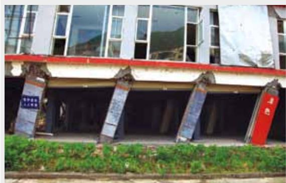
圖1. 建築物的柱在水平地震中歪斜受損的現象(拍攝於四川省北川老縣城汶川地震遺址)。
