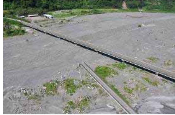
圖 21. 金崙溪舊軒子崙溪橋南北引道 在大水時淪為行水區，被洪水 沖毀，雖然橋樑主體沒斷，遠 看有如斷橋。
