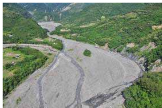
圖 12. 新興部落位於大竹溪滑走坡之低位河階臺地，其對岸則為河道轉彎之攻擊坡，河岸屬變質砂頁互層，岩性軟弱不堅硬，易風化，遭受河水沖擊侵蝕時，邊坡不穩定。
