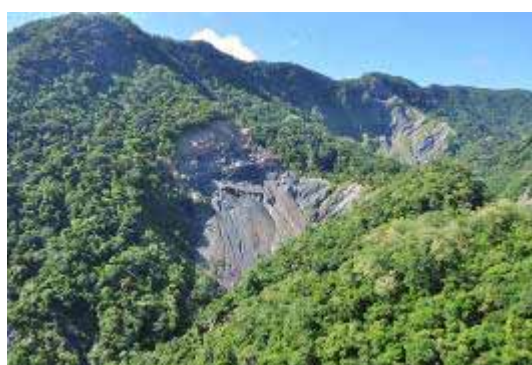
圖 17. 大竹溪上游屬潮州層大武段變質砂頁岩互層地層，岩性軟弱不堅硬，易風化崩塌，幾乎成了寸草不生之惡地（圖中間處）。
