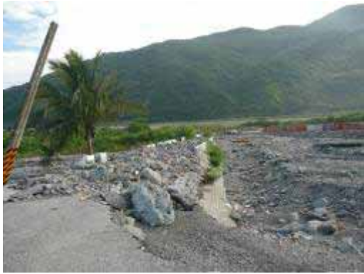
圖 20. 莫拉克颱風過後，金崙溪流 域於災後緊急應變築堤修 路的情形。
