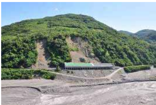
圖 22. 大竹溪明隧道山崩、土石流使 道路毀壞，通往土坂之臨時便 道改駛河床。
