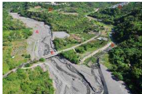
圖 23. 大竹溪流域臺坂溪(A)、拉里 巴溪(B)、呀里巴(C)、臺 坂(D)與臺坂橋(E)。
