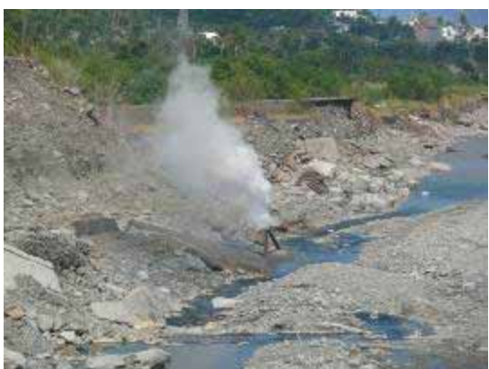
圖 18. 金崙溪金崙地熱鑽探井一帶，在莫拉克颱風災後，道路及河岸受損情況。
