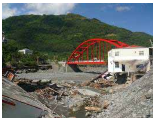
圖 19. 金崙溪金崙溫泉觀光渡假村在莫拉克颱風災後，金崙溪潰堤，屋倒道路毀，慘不忍睹。
