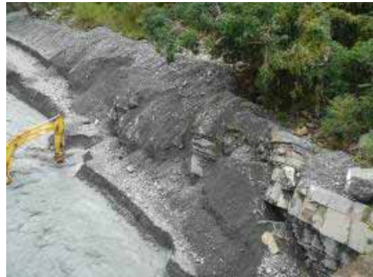
圖 10. 金崙溪莫哥布各巴拉奧橋下游河段屬大溪透鏡體變質砂岩段，崩塌淤塞填高河床，需時時挖掘疏浚，以維持河道水流暢通，避免低窪河段潰堤氾濫成災。
