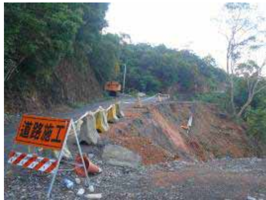
圖 29. 大武東 70 線公路往新化村新化國小沿線的紅土臺地，在莫拉克與凡那比颱風災後，至今道路仍中斷，由工程單位積極搶修中。
