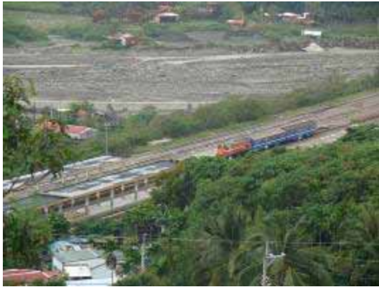
圖 28. 大武溪南迴鐵路大武站及滿地零亂的大武溪
