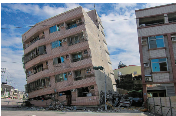
圖3 在2016年美濃地震時傾斜半倒的歸仁幸福大樓
