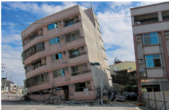
圖3 在2016年美濃地震時傾斜半倒的歸仁幸福大樓
